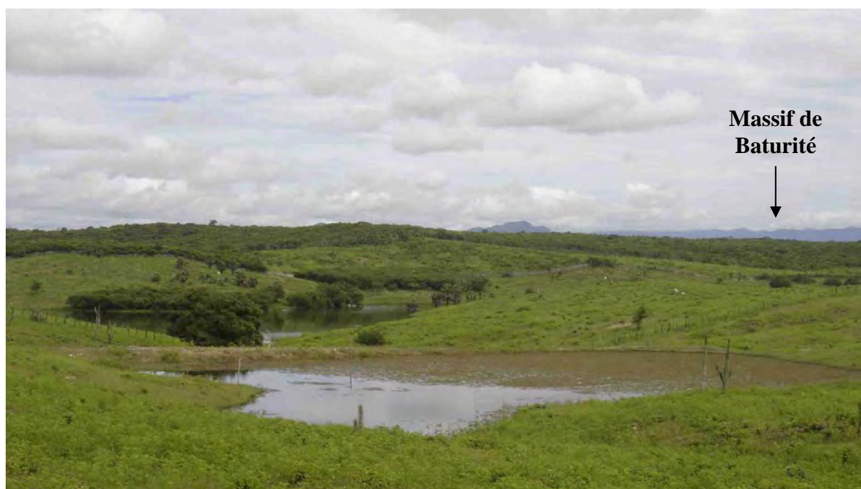
Photo 79 – Disposition classique des açudes en chapelets dans l'axe des talwegs de la plaine semi-aride du Sertão , piémont oriental du massif de Baturité (Itapiuna). Ce dispositif est similaire à celui des chain tanks de l'Inde semi-aride. Seule l'utilisation des réservoirs diffère entre les deux régions : dans le Nordeste, la plupart des retenues superficielles sont destinées à l'abreuvement du bétail et à l'approvisionnement de la population en saison sèche, tandis que l'irrigation est le principal mode de mise en valeur des tanks indiens. Cliché F. Bétard.
