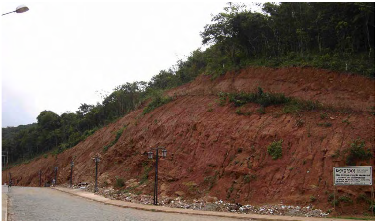
Photo 11 – Coupe dans une demi-orange à Guaramiranga. Le manteau d’altération, dont la puissance atteint ici les 25 mètres avant d’atteindre la roche saine perceptible au niveau de la route, est issu de la décomposition poussée du gneiss précambrien. Ce manteau profond et de couleur rouge, dont la consistance très friable est typiquement celle d’une isaltérite kaolinique, est associée dans la partie supérieure des profils à des Acrisols rouges-jaunâtres où les horizons pédologiques atteignent régulièrement les 2 mètres. Cliché F. Bétard.
