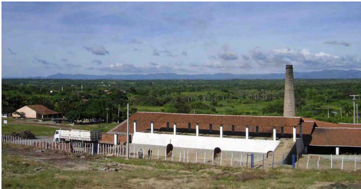
Photo 36 – Briqueterie du Sertão dans les environs de Canindé, piémont occidental du massif de Baturité. Ces briqueteries s'approvisionnent en matériel argileux en provenance des carrières situées dans les bas-fonds plats humides à Planosols (centre de la photographie, bas-fond humide drainé par un tributaire du Rio Canindé, souligné par les forêts-galeries de palmiers carnaúba). A l'arrière-plan, l'escarpement occidental du massif de Baturité dominant de 600-900 mètres la basse plaine à inselbergs du Sertão . Cliché F. Bétard.
